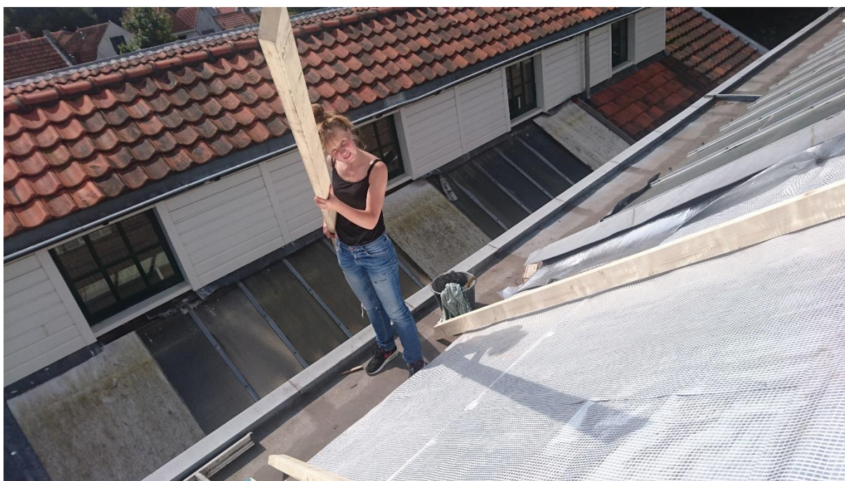
Het volledig isoleren en renoveren van het dak, 2017.
