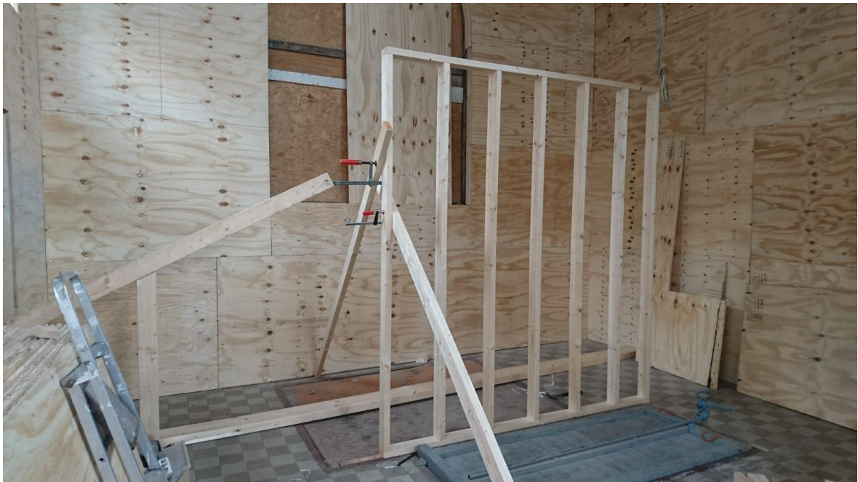
Begin van kantoor en backstage, 2018.
