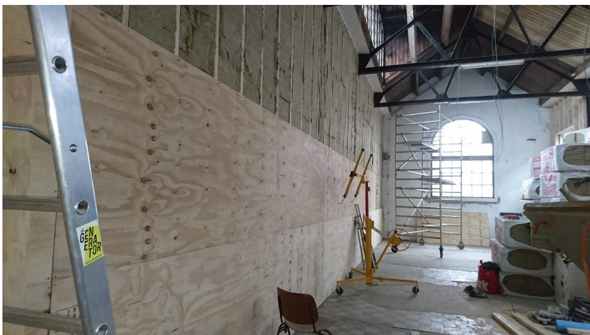
Voorzetwanden en isoleren, 2018.
