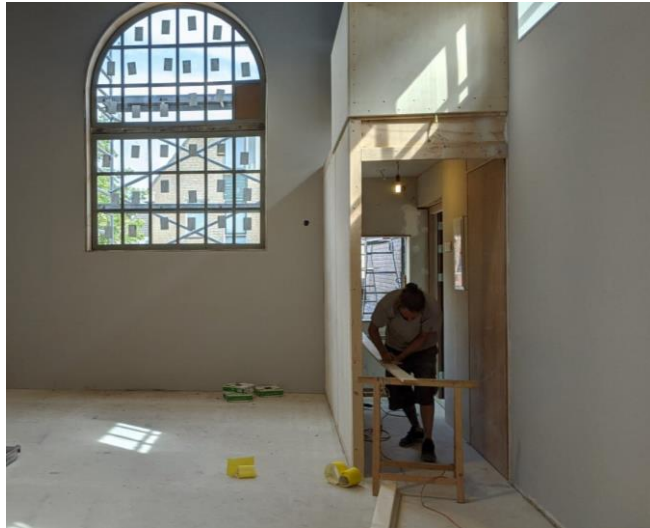
De gehele bouwperiode vele oude fabrieksramen gerenoveerd en van dubbelglas voorzien.
